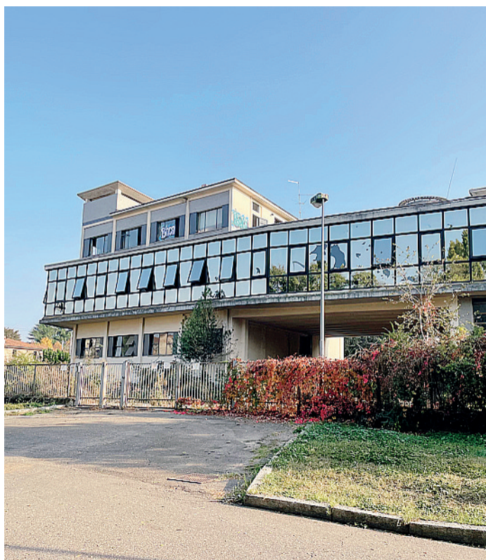
Il vecchio sito produttivo della Fardeco, da tempo dismesso Archivio
